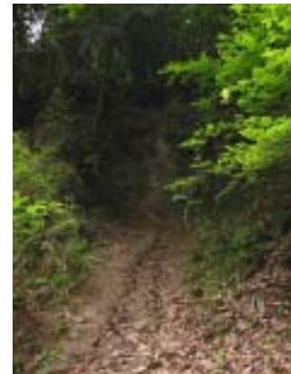
写真 9.5 マサ土の法面崩壊
