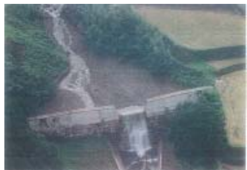
写真 1.3 白猪谷 堰堤により捕捉された土石
