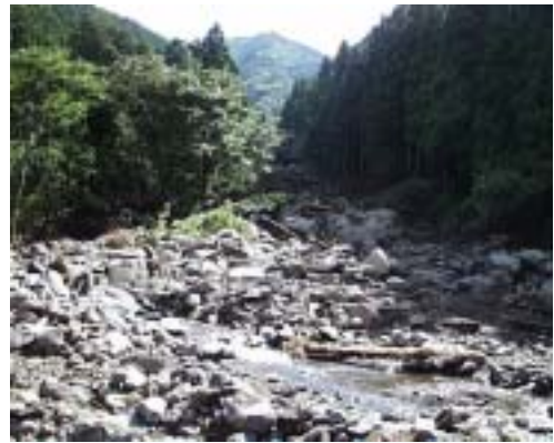
写真 1.1 根無谷 堰堤上流に捕捉された土石
