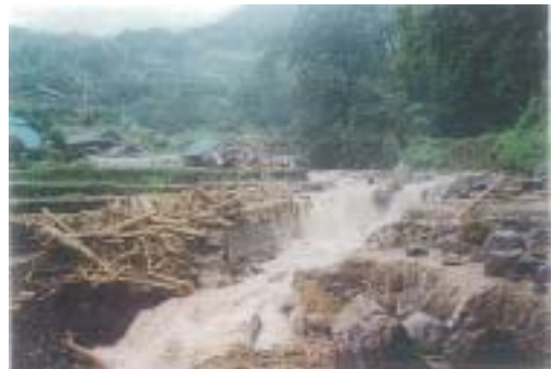
写真 1.2 惣田谷 土石・流木による流路工被災
