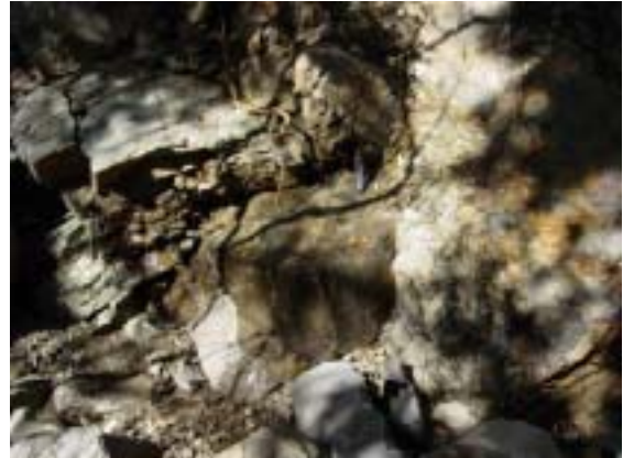
写真 - 4 上流 50m 砂岩・泥岩露出状
