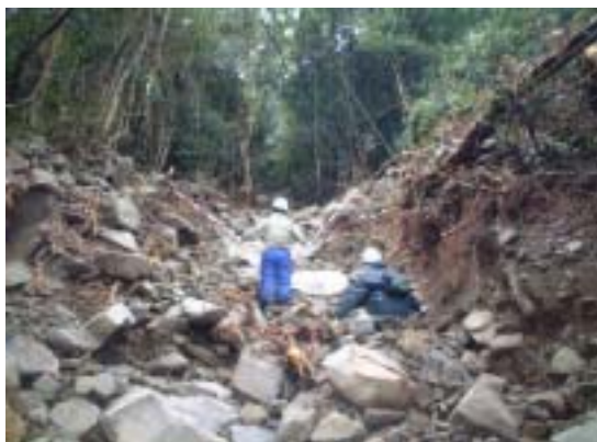
写真 - 3 送流区間の状況。 路面より比高差50m、斜長100m地点。 勾配25°の直線的な河道形状。断面はW=3m H=1~2m。
