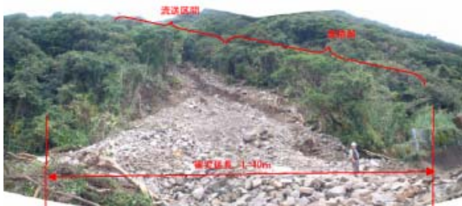
写真 - 1 土石堆積部全景
