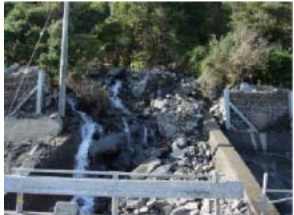
写真 - 2 幅約5mの流路を埋める流出土石。 人頭大程度のものが多いが、長径1m を超えるものも含まれる。
