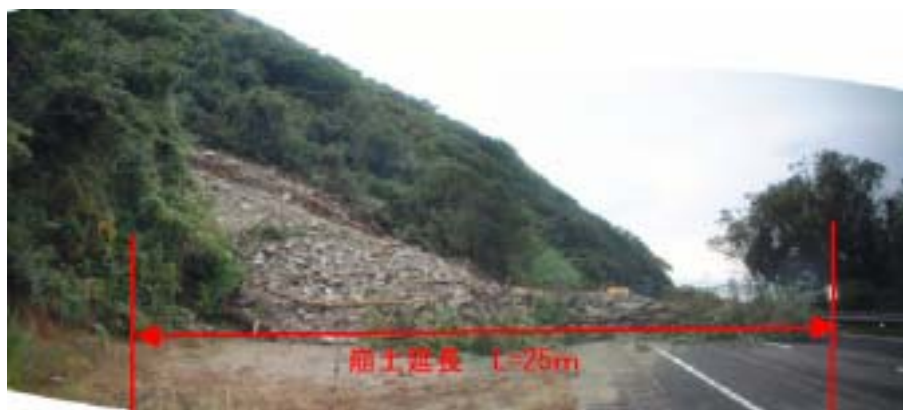
写真 - 2 国道部 堆積状況 (終点側より)
