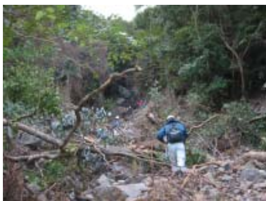
写真 - 3 崩壊発生箇所 流出土砂の発生源となる岩盤崩壊箇所 （推定崩壊規模：15×20×5m程度）
