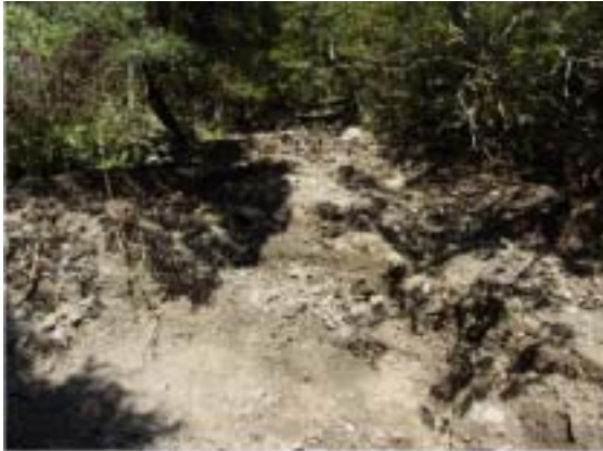
写真 - 3 上流 170m 表層崩壊状
