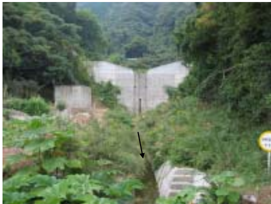
図 4.7 西満野川土石流捕捉ダム
