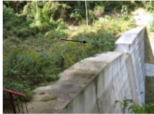
図 3.11 溪岸侵食防止ダム
