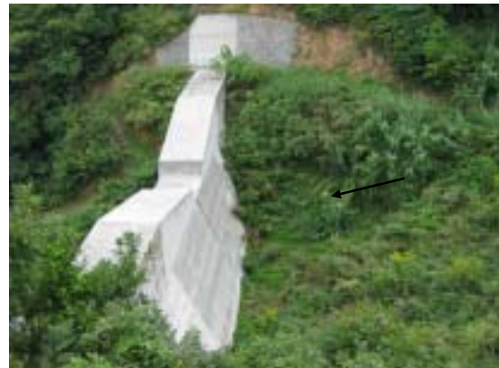
図 4.8 西満野川土石流捕捉ダム
