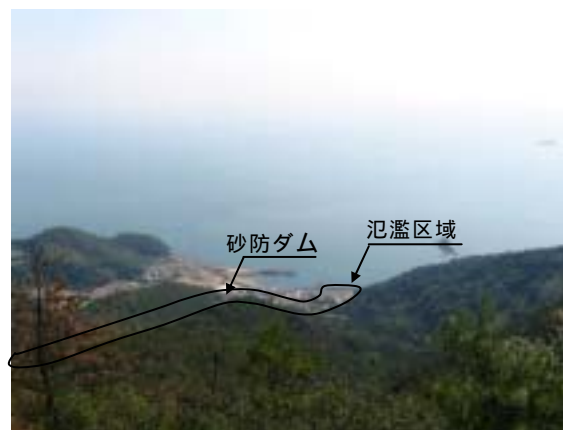
図 5.3 崩壊区域・氾濫区域
