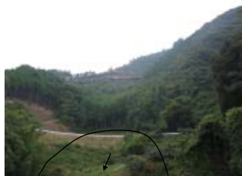
図 4.4 崩壊した町道
