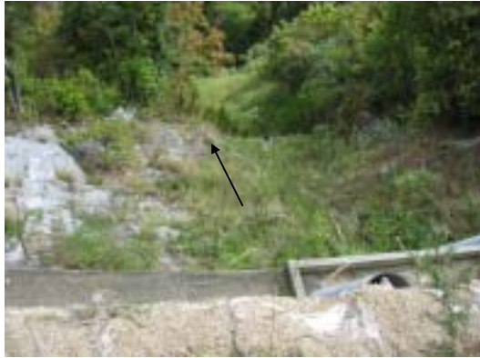
図 3.10 モルタル吹付による法面保護
